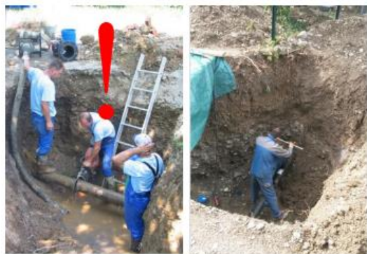
Prikaz nevarnega dela brez osebne varovalne opreme v nezavarovanem izkopu
